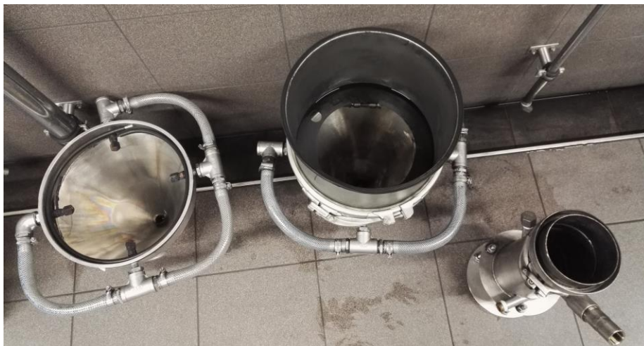
Abbildung 2: Schrittweise Optimierung der PAK-Benetzung von links nach rechts. Heutige Lösung rechts: ein Wasserfilm fließt gleichmässig wie ein Wasserfall über einen Zylinder und zieht die PAK mit.
