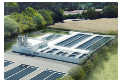
Abb. 2: Ansicht der Anlagenerweiterung im Anschluss an die bestehenden Nachklärbecken.
