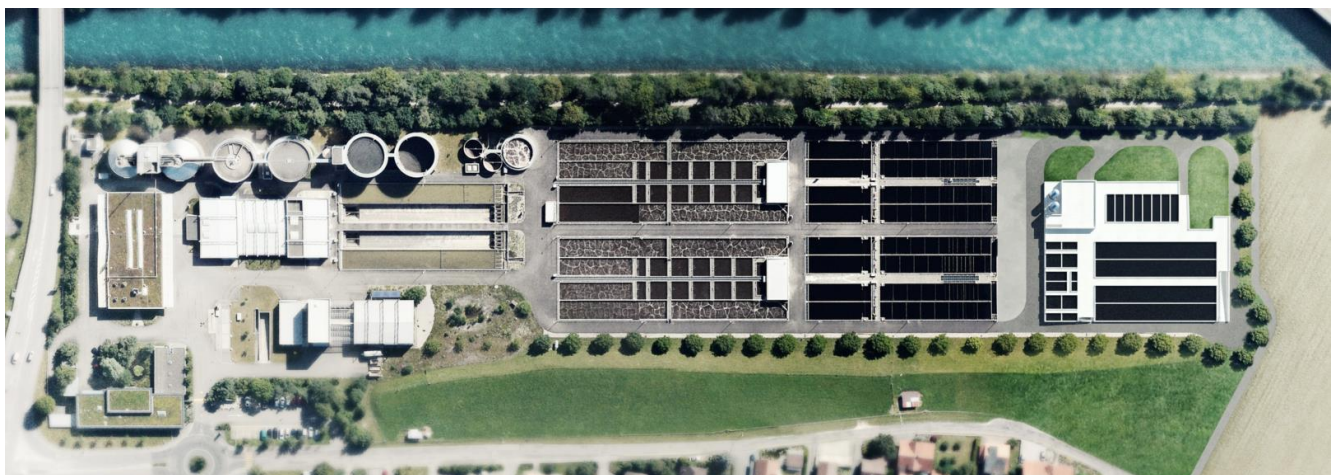
Abb. 3: Luftansicht der bestehenden und neuen Anlagenteile
