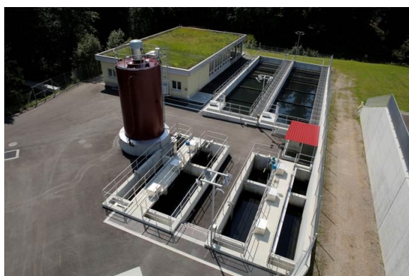
Figure 5 Etape CAP réalisée selon le procédé d'Ulm dans la STEP de Bachwis (Herisau).
