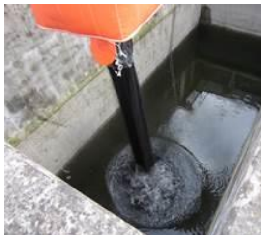
Figure 4 Introduction du CAG dans la cellule filtrante.
