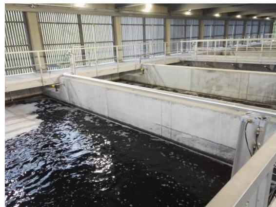
Abbildung 5: GAK-Filtration als Nachbehandlung nach Ozonung auf der ARA Altenrhein
