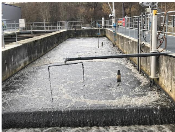
Abbildung 3: PAK-Dosierstelle Belebtschlamm-Biologie ARA Wetzikon
