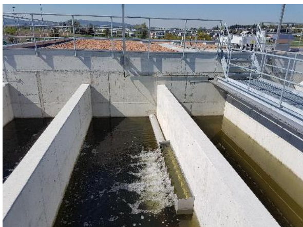
Abb. 6 : Dach des neuen Gebäudes mit der Sandfiltration im Vordergrund (ARA Eich, Bassersdorf)
