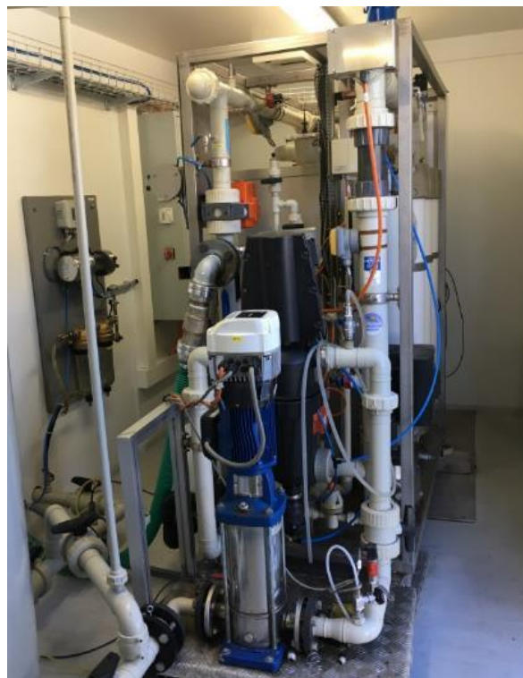
Abb. 3 : Pilotanlage zur Ultrafiltration.
