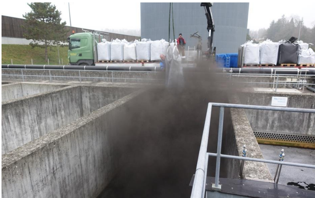
Abbildung 5. Wiedereinbau reaktivierte GAK der ARA Bülach, Februar 2018 (Foto: A. Joss Eawag). Zu sehen ist die grosse PAK-Wolke, welche in Zukunft vermieden werden soll.
