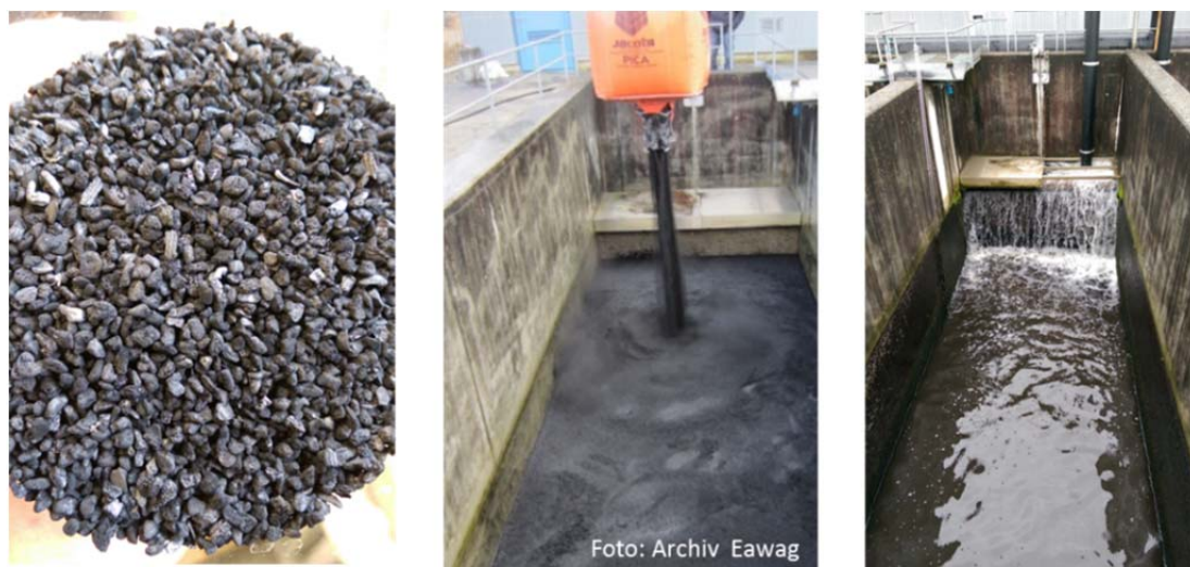
Figure 2. Le CAG Aquasorb 5010 utilisé dans le filtre (à gauche), le remplissage des filtres en décembre 2014 (au centre) et une cellule avec une arrivée d'effluent (à droite).
