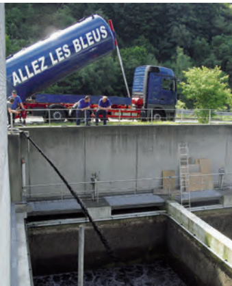
Abb. 1: Einfüllung von GAK in Filterbauwerk der Kläranlage Wuppertal-Buchenhofen (Umnutzung vorhandener Filterzellen)
