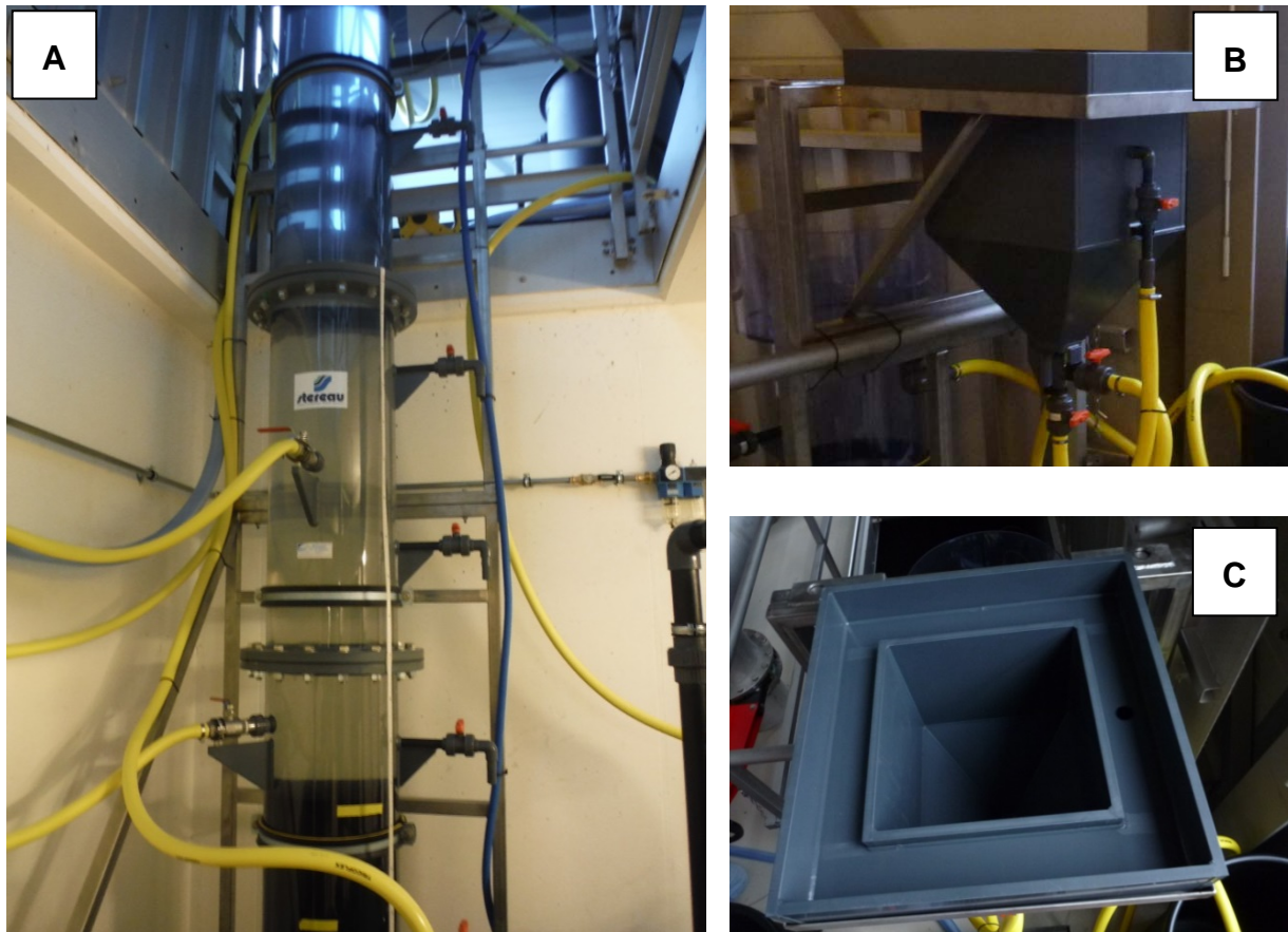
Abbildung 2: A: Pilotreaktor für ein µGAK-Wirbelbett auf der STEP de Penthaz. B & C: Separate Installation für die Benetzung und das Waschen der µGAK vor deren Dosierung in den Reaktor.
